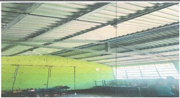
Foto 5: Cambio de techo y alumbrado eléctrico de aulas
